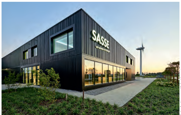
Neubau Fa. Sasse in Bremerhaven von schultz sievers.architektur BDA.
