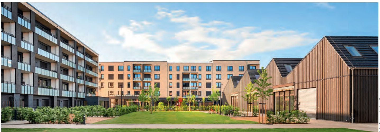
BlauHaus-Ensemble mit den zwei fünfgeschossigen Wohngebäuden und dem eingeschossigen Werkstattgebäude (Blaue Manege), 2019
