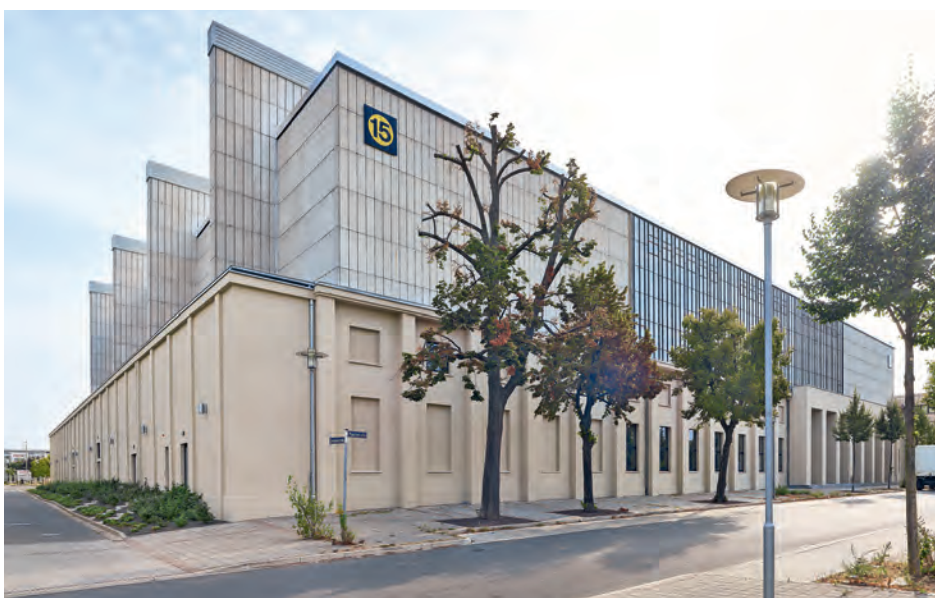
Messehalle 15 nach dem Umbau, 2019
