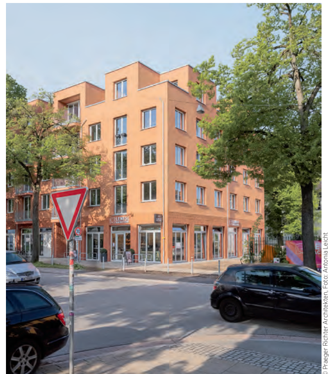
Bremer Wohnprojekt „Karl“ in der Friedrich-Karl-Straße, Bremen.
