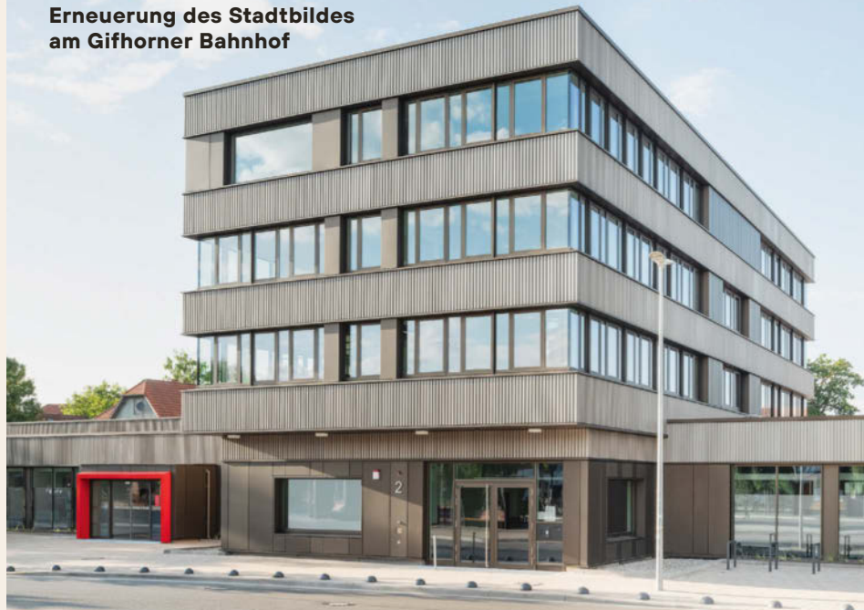
Links: Revitalisierung und baukulturelle Aufwertung eines Verwaltungsgebäudes am Bahnhof. Unten: Vor den Maßnahmen.
